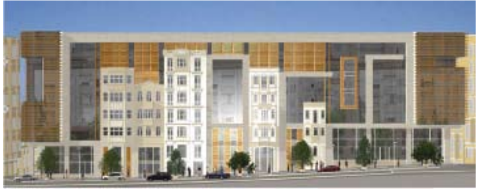
Tarlabaşı projesinde Bulvara bakan yapı adalarından birinin yeni silüeti. Eski cepheler korunuyor gibi görünse de yıkılıp yeniden yapılmış bir dekordan ibaret. Görünen kapılar da kapı değil, bina girişi yan cepheden verilmiş zira.
