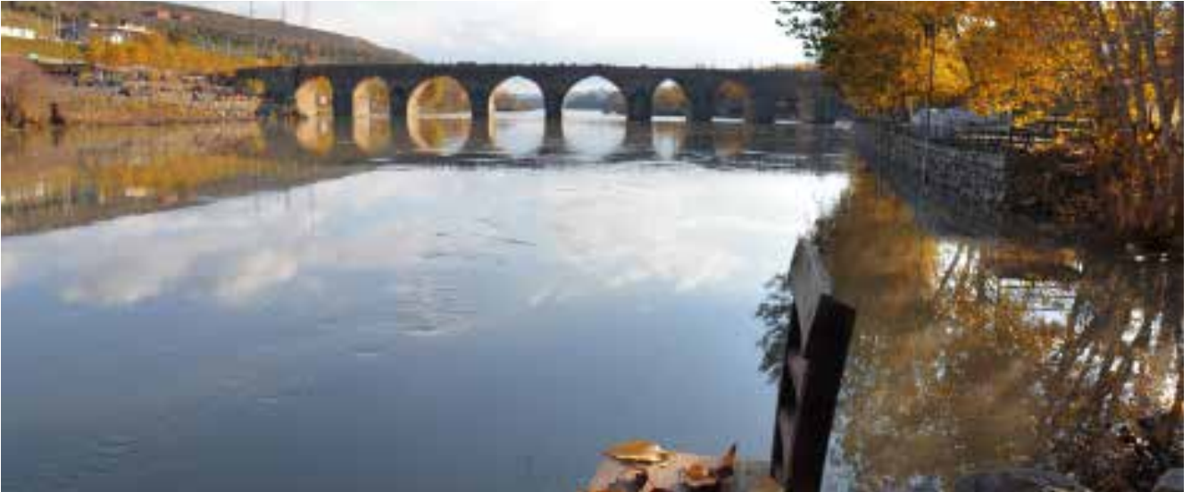
Dicle üzerindeki On Gözlü Köprü 1085 yılında Mervaniler döneminde yapılmış. Eski Silvan yolu üzerinde yer aldığı için Silvan Köprüsü olarak da adlandırılan köprünün yapımında bölgeye özgü bazalt taşı kullanılmış.
