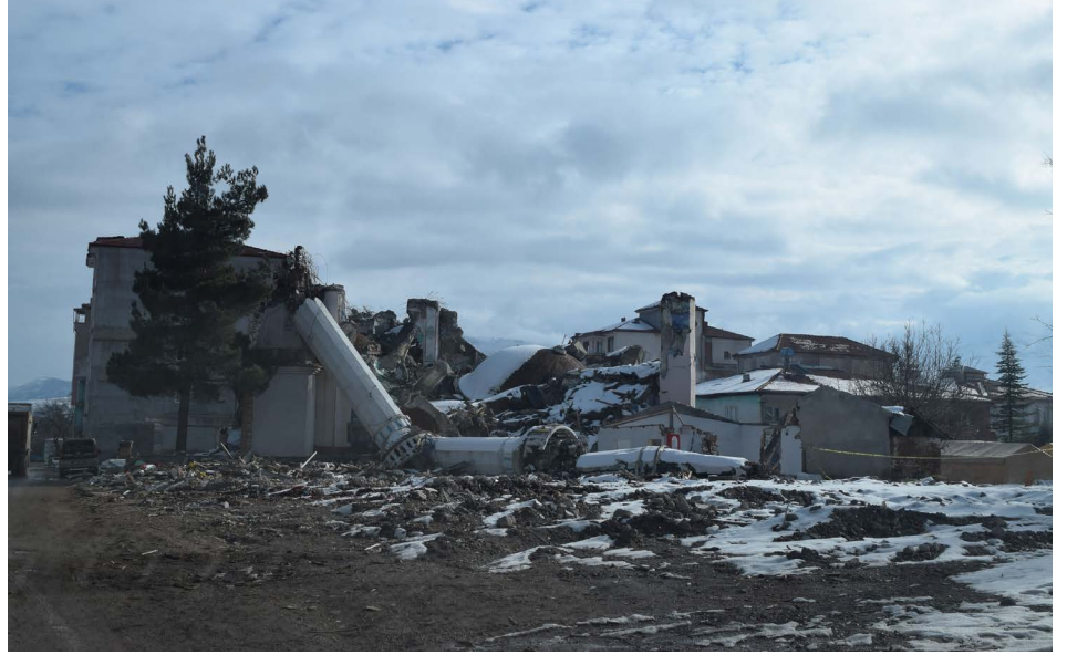
Malatya'da enkazların önemli bölümü kaldırılmış olsa da Doğanşehir'deki bu cami enkazı gibi kaldırılmayı bekleyenler de var.
