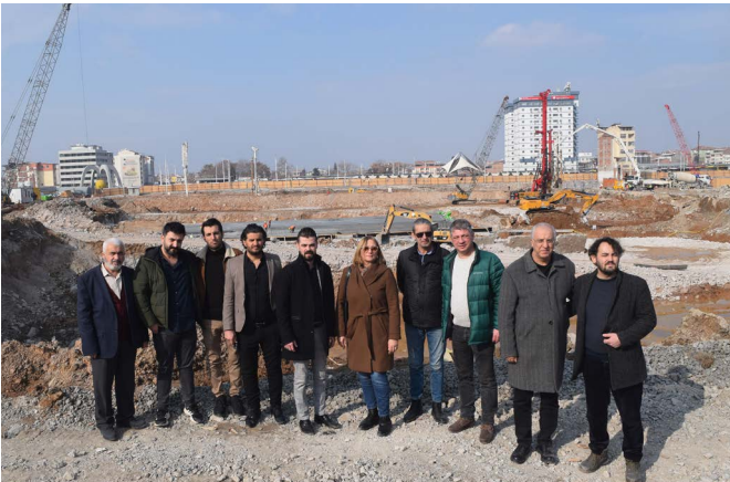
Yıkımların tamamlanmaya yaklaştığı kentin merkezinde geniş bir alan yeni çarşı olacak şekilde yeniden inşa ediliyor.
