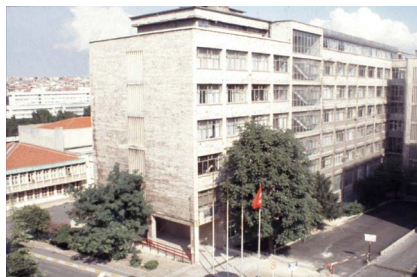
Fakültenin 1970'te kullanılmaya başlanıp Eylül 2019 depreminin ardından boşaltılıp yıkılan üçüncü binası.
